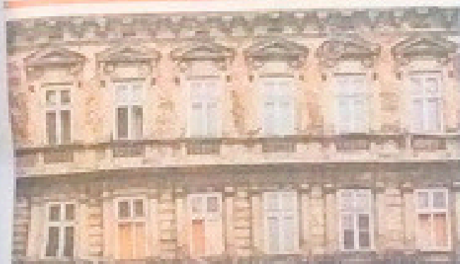
Balancesakt: Bausubstanz sanieren und für Zukunft bewahren.
