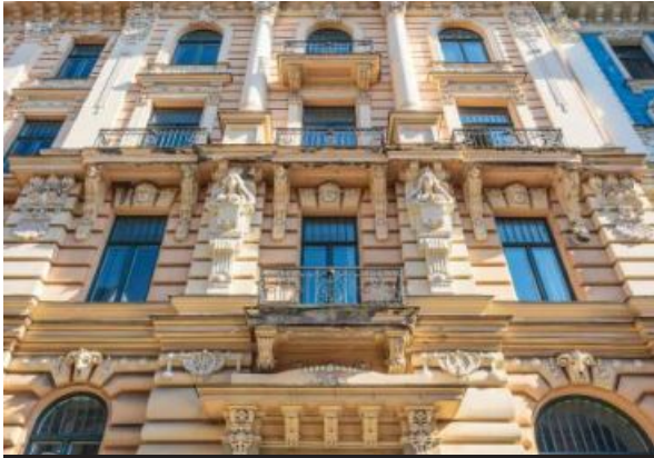
Nicht jeder Eingriff in die Bausubstanz ist ein Fortschritt.
